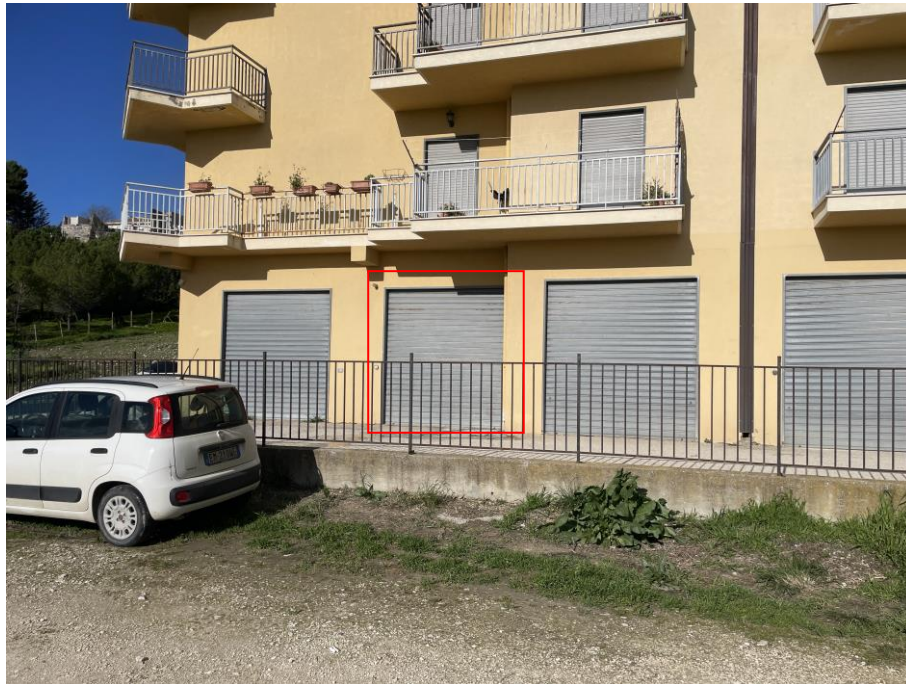
Foto n. 3 – Vista ingresso box auto da via Nilde Iotti
