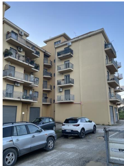
Foto n. 5 – Vista prospetto secondario
